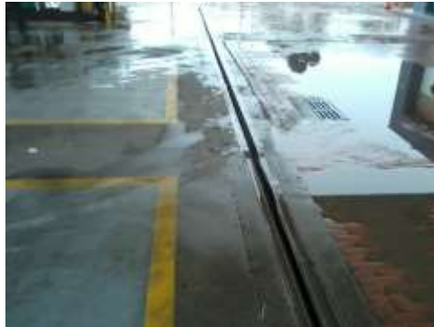
Fotografía 3. Cuneta perimetral de pista
